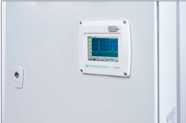
montaje en el armario de distribución
