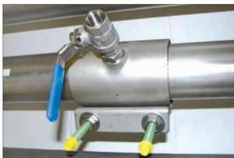
Si en una tubería existente no hay ningún punto de medición con válvula esférica de 1/2", se puede ejecutar un punto de medición rápida y económicamente con ayuda de abrazaderas de perforado. La abrazadera de perforado se enfunda sobre el tubo y se fija sobre la barra roscada. La amplia junta de goma es estanca a la presión hasta 11 bar. Con ayuda del dispositivo de perforación se puede perforar con la válvula esférica de 1/2" la abrazadera de perforado en la tubería existente.
